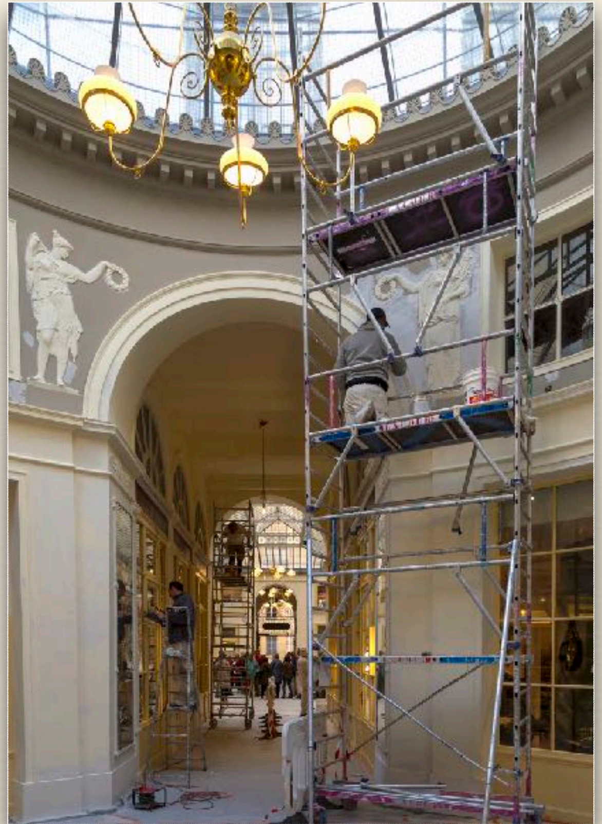
Travaux de restauration en cours par les monuments historiques
